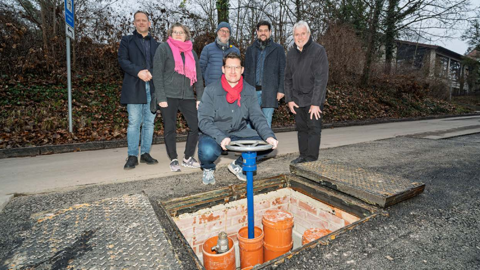
OB Dominik Sauerteig (vorne) öffnet symbolisch die Fernwärmeleitung zum Grünflächenamt.
